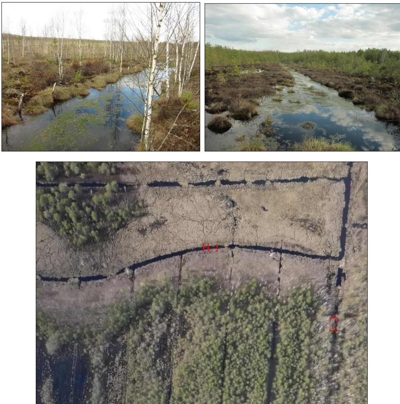
Рисунок 3.3 – Современное состояние существующей системы осушительных каналов на участке планируемой деятельности
